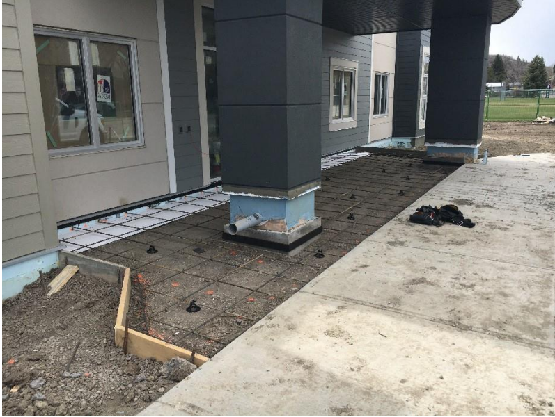
Rebar and Forms for Entrance Pour
